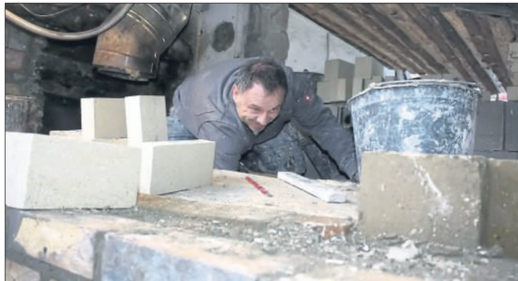
Ofenbauer Gerd Zepp ist extra aus der Eifel nach Werdohl angereist, um den neuen Holzofen von Bäckermeister Hubert Deitmerg zu bauen. ▪ Fotos: Wieschmann
