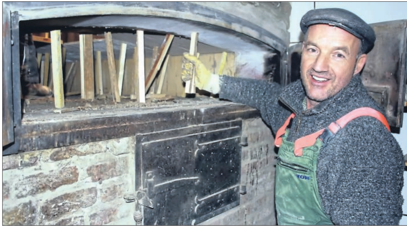
Eine Schablone aus Stützhölzern und einer Spanplatte zeigt das neue Kreuzgewölbe des Holzofens an. Doch bevor es am 1. Februar wieder losgehen kann, muss zunächst auf kleiner Flamme geheizt werden, um die neu verbauten Steine zu trocknen.
